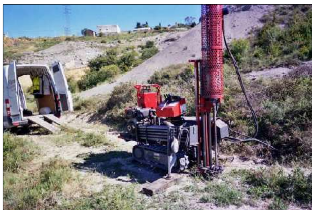
Fotografía 5.- Emplazamiento ensayo DPSH
